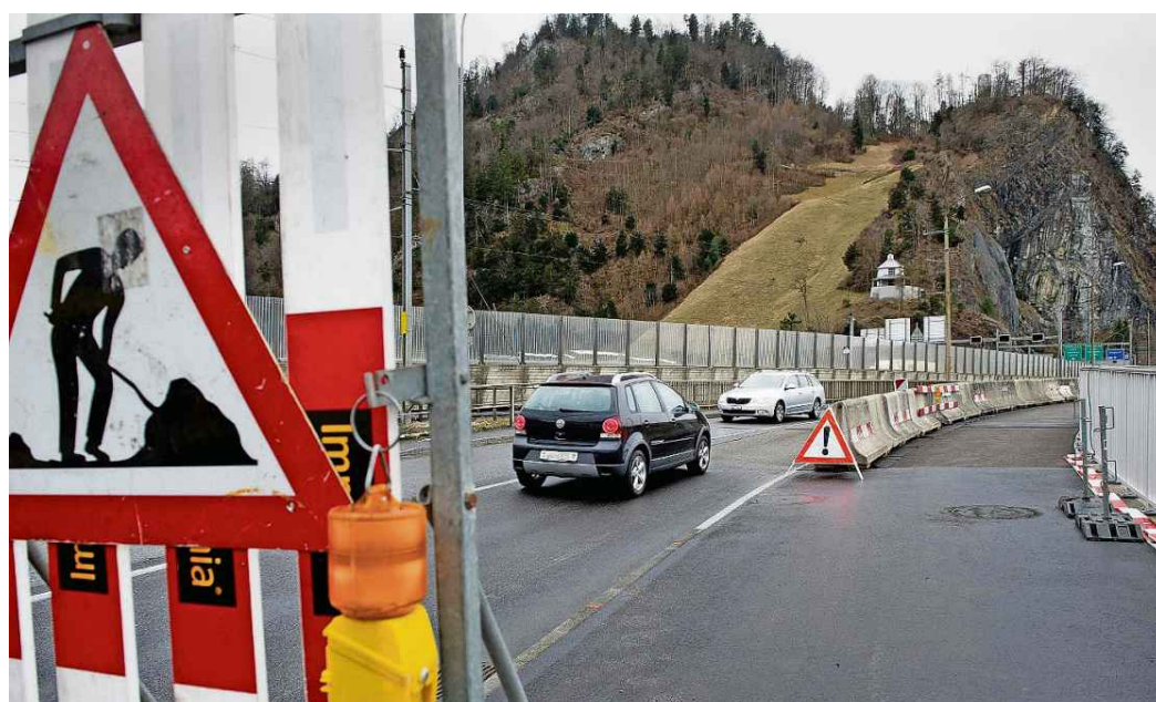
Bis Ende Oktober wird an der Achereggbrücke gebaut. Bild Corinne Glanzmann
